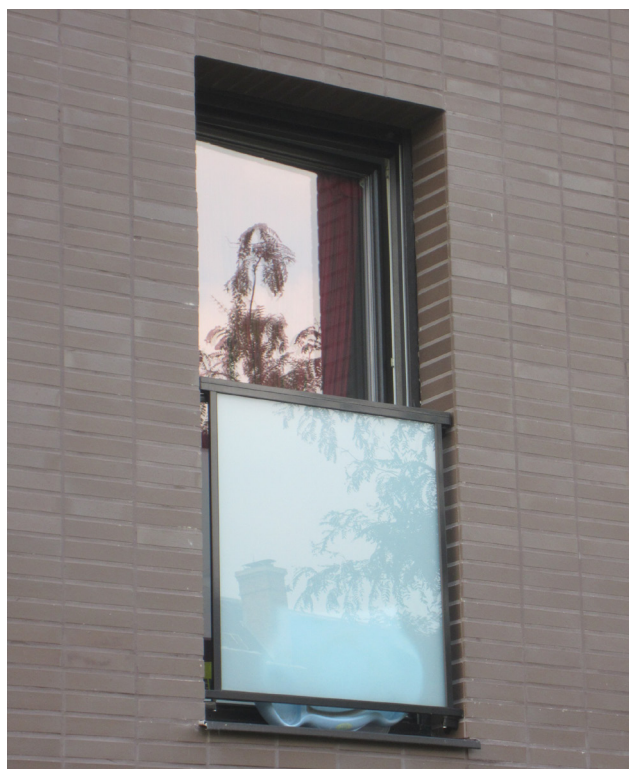
Les garde-corps en verre dépoli et PVC plaxé alu
