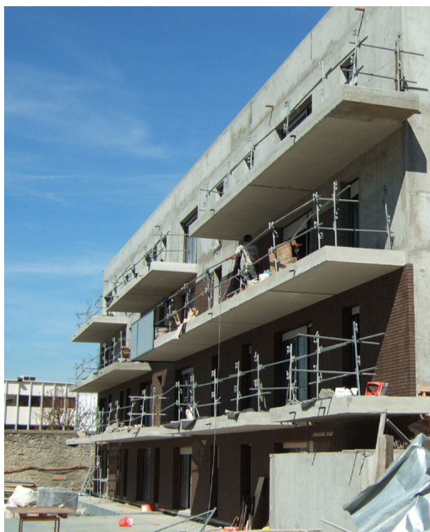
Structure en béton et parement brique avec isolation thermique par l'intérieur (ITI)
