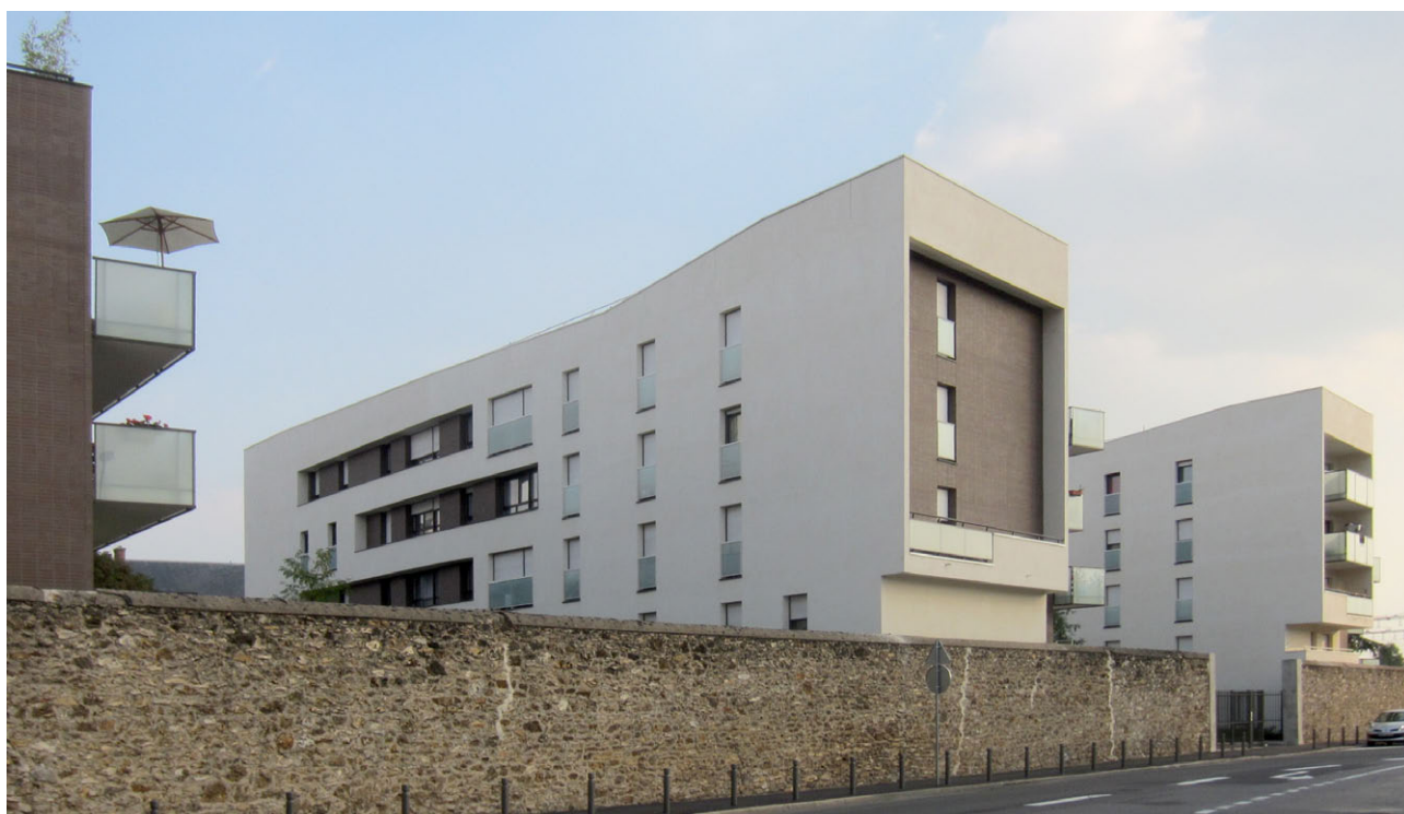
Le mur d'enceinte conservé est ponctuellement percé.
