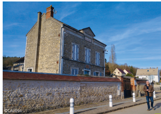
Le bâtiment de l'ancienne école est en cours de reconversion afin d'accueillir une nouvelle activité.
