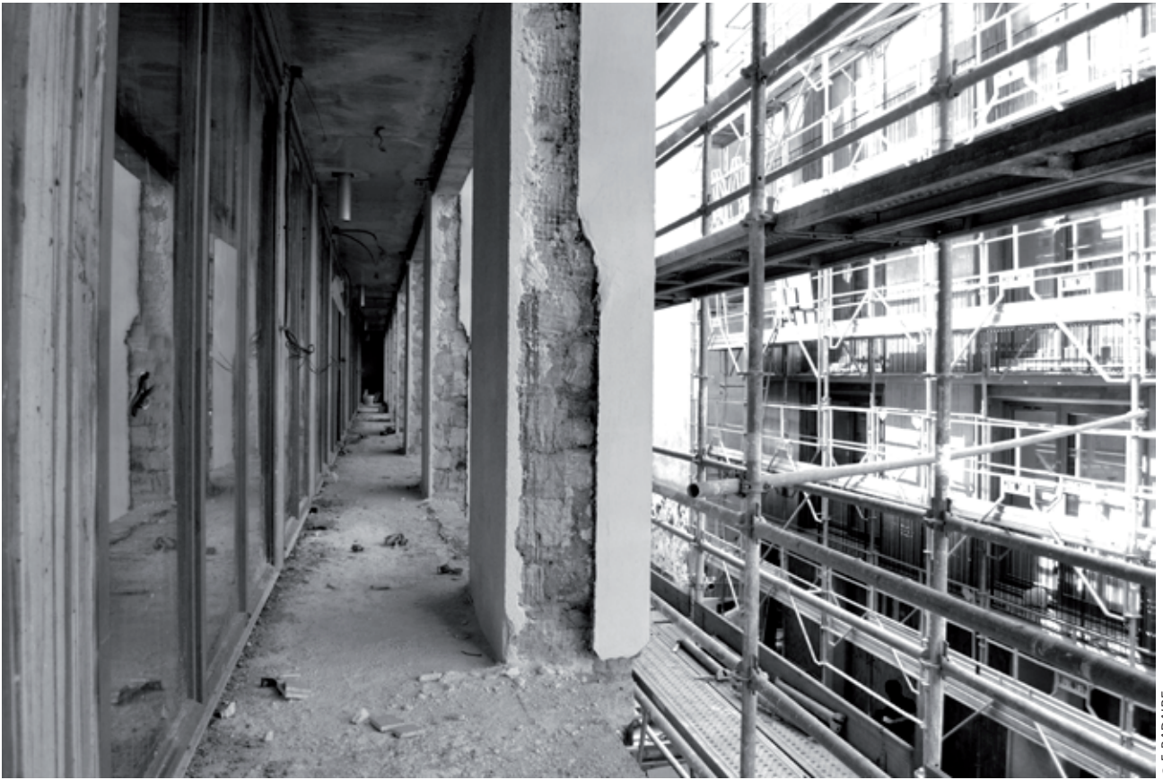
Création d'une nouvelle façade en retrait de l'existant (bâtiment B)
