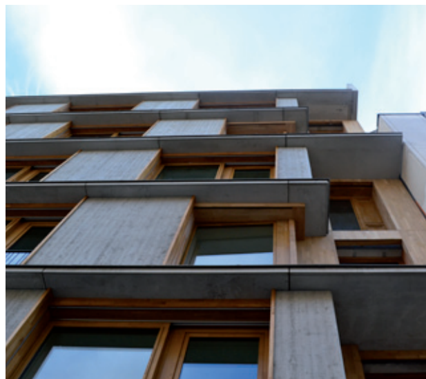
Vue sur les panneaux préfabriqués de la façade, en fin de chantier
