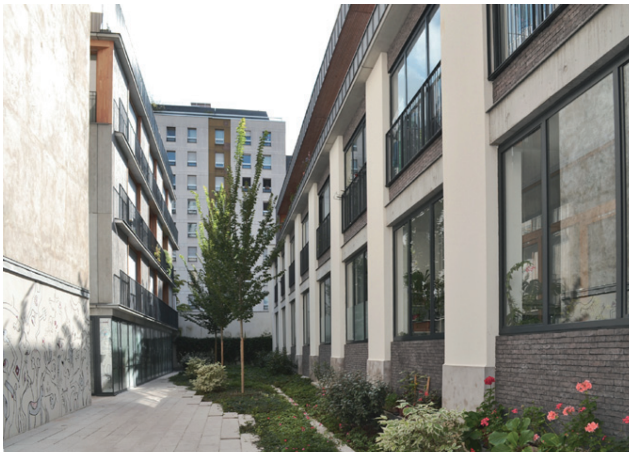
Vue sur la cour, le bâtiment C à gauche et le bâtiment B (halle réhabilitée et surélevée) à droite
