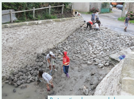
Restauration du pavage de la mare
