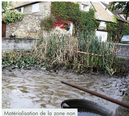
Matérialisation de la zone non concernée par les interventions
