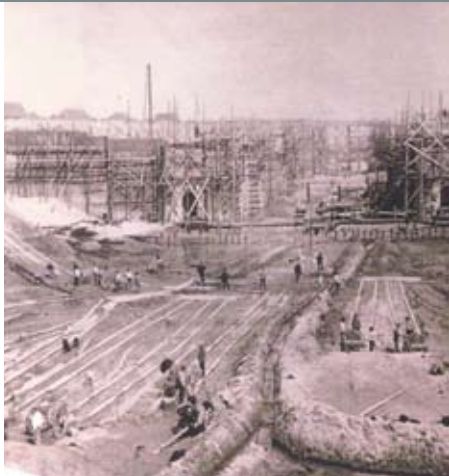
Construction des écluses dans la percée à travers les dunes.
