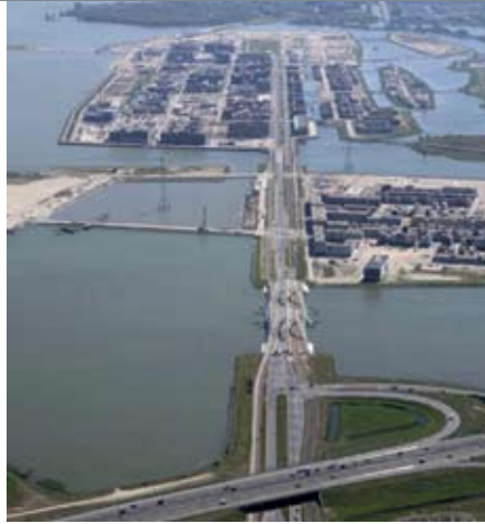
IJburg, extension de la ville en construction depuis 1997.
