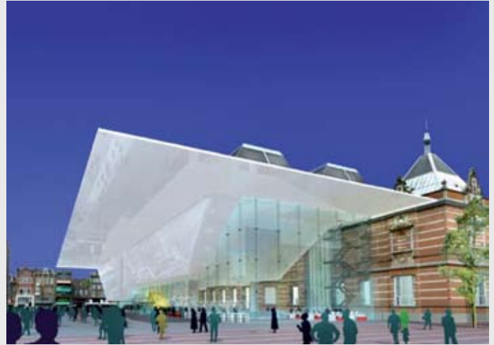
Extension du musée d'Art moderne d'Amsterdam, en cours de réalisation.
