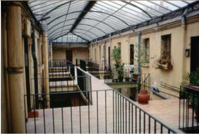
Cité Napoléon, logement ouvrier en ville, rue Rochechouard à Paris : un des rares exemples d'une politique qualifiée de dangereuse et qui fera long feu.
