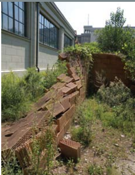
L'œuvre d'Urs Fischer qui met en scène la dégradation d'un mur de briques.
