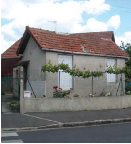
Un cabanon à Villemoisson-sur-Orge : le logement minimum sur une parcelle de lotissement jardin.
