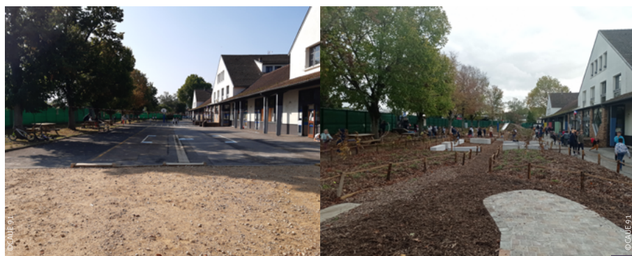
Dans le fond de la cour, sont aménagés de nombreux espaces pédagogiques, amphithéâtre, chemin d'eau, potager et verger.
