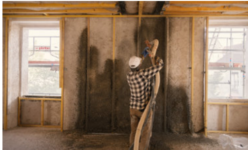
Le chanvre projeté pour isoler les murs, une technique en plein essor.
