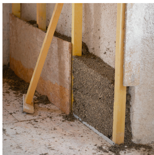
Technique de chanvre banché. Rien ne se perd !
