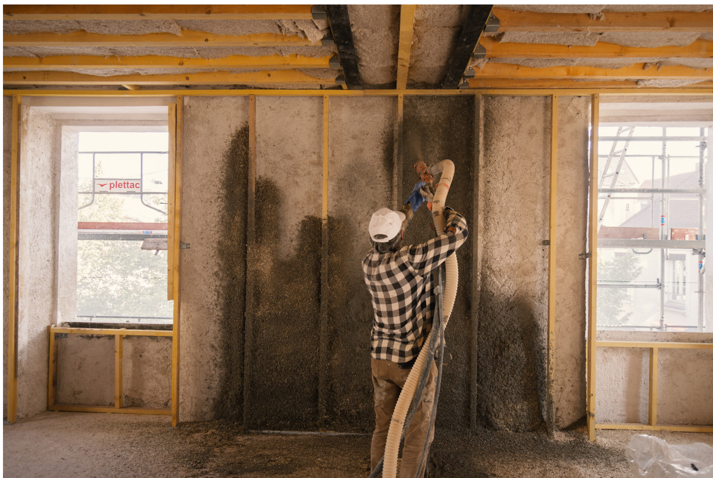
Le chanvre projeté pour isoler les murs, une technique en constant développement. Action menée depuis 2020.
